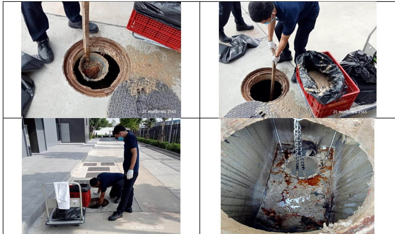
รูปที่ 2-5 การดูแล ตรวจสอบประสิทธิภาพระบบของบำบัดน้ำเสีย
